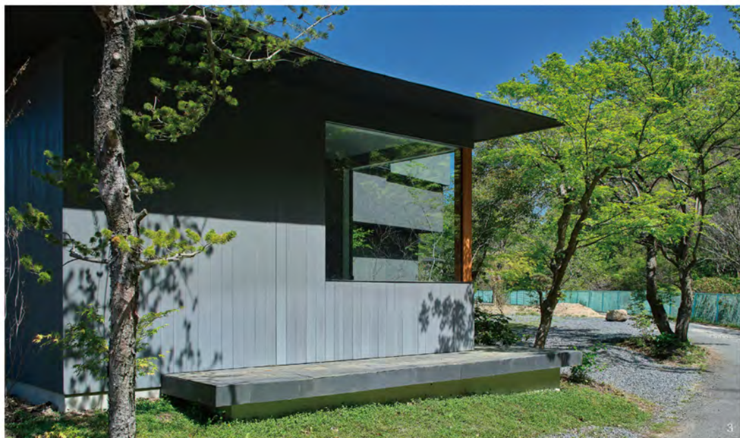
1.手を伸ばせば森に届くような、一面ガラス張りの洗面台。窓の光が漆喰壁に静かな陰影をつける。 2.寝室は構造を現しにして、小屋のような素朴な雰囲気。雨は隣家を避け、高窓に山だけを映す。 3.洗練された抜け感をもたらすコーナー窓。建物を縁取る土間に腰掛けて、近所の人と世間話も。
